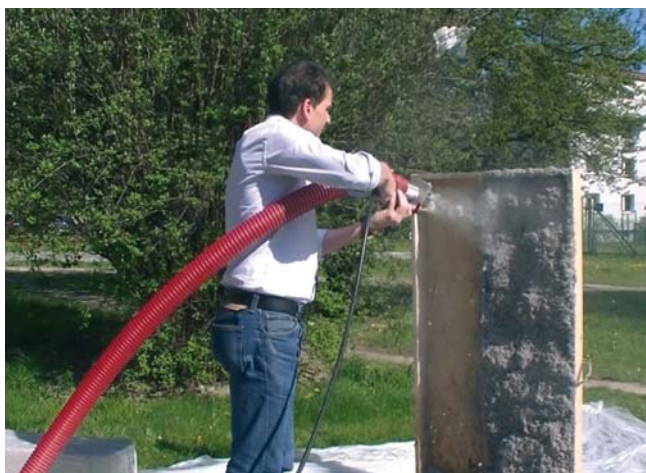
FOT. 1. Pokaz natrysku celulozy na ściankę z płyty OSB; fot.: DEROWERK
