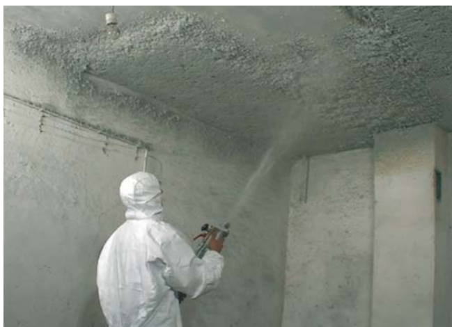
FOT. 3. Ocieplanie stropu piwnicy zaprawą termoizolacyjną na bazie wełny mineralnej i cementu; fot.: DEROWERK
